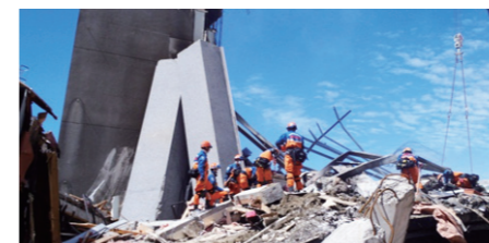
クライストチャーチ CTV ビルでの捜索救助活動 (平成 23 年 2 月ニュージーランド南島地震災害)
