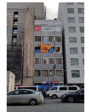
出火建物外観
