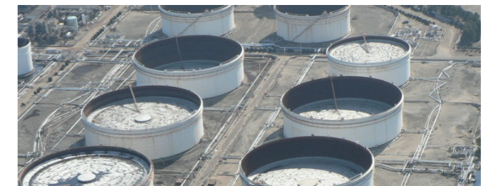
屋外タンク貯蔵所からの危険物が流出 / 東日本大震災（仙台市消防局提供）
