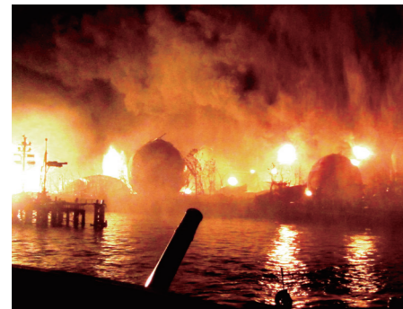
石油コンビナート火災（東日本大震災）
